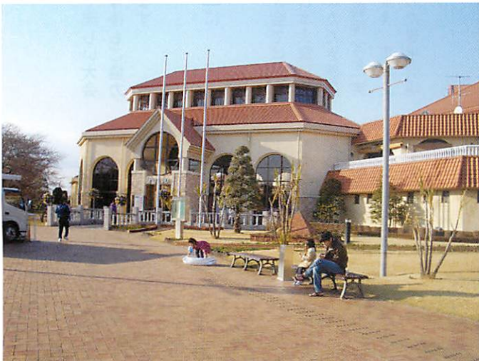
▲プールの外観
