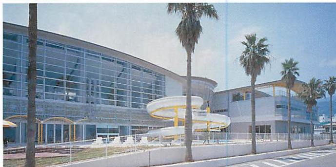
▲ウォータースライダー面 からの外観
